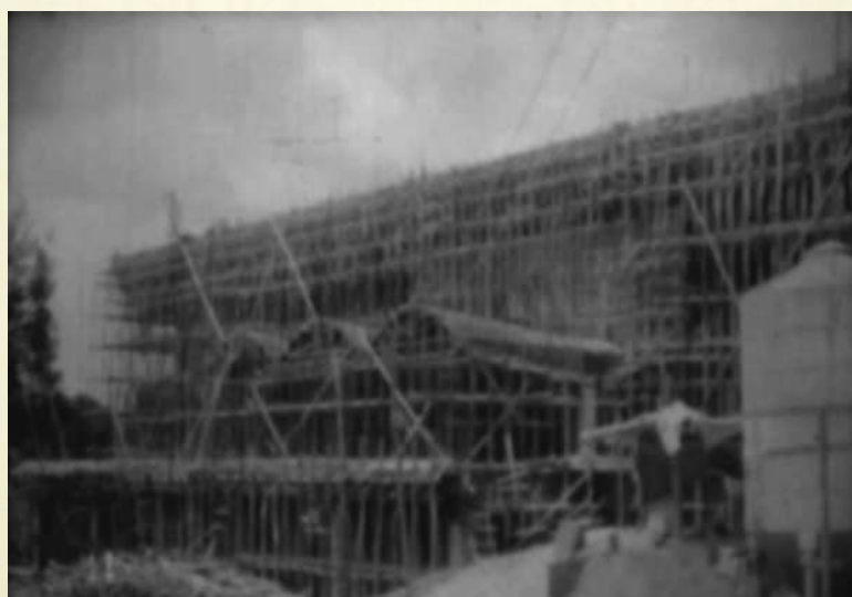
ขณะก่อสร้างอาคารรัฐสภา ถนนอยู่ท้องใน และบริเวณถนนหน้าอาคาร
