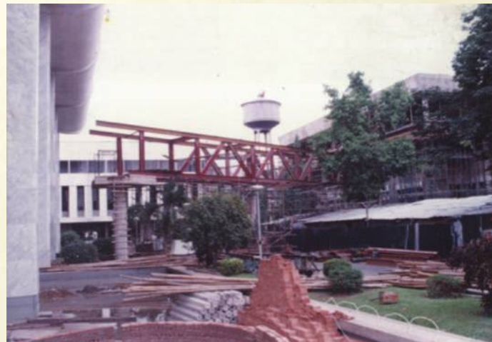
การก่อสร้างอาคารรัฐสภา ๒
